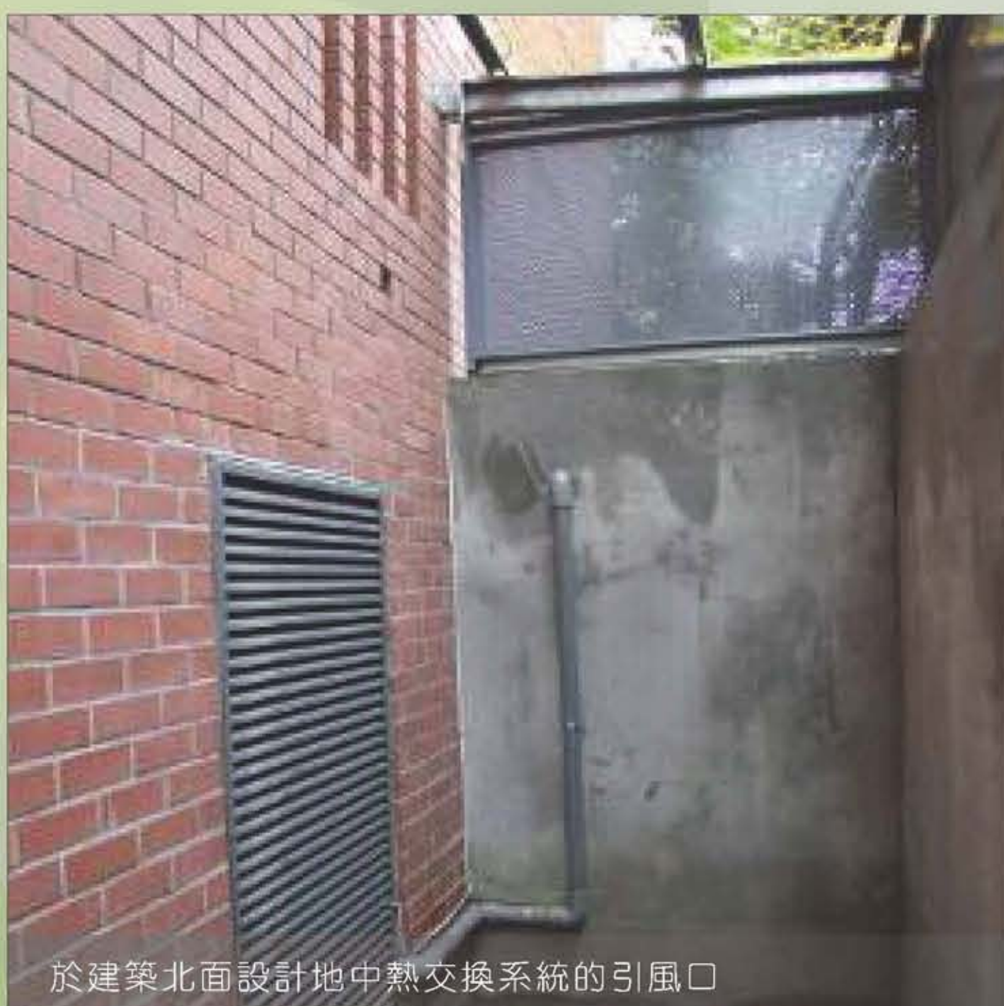
於建築北面設計地中熱交換系統的引風口
