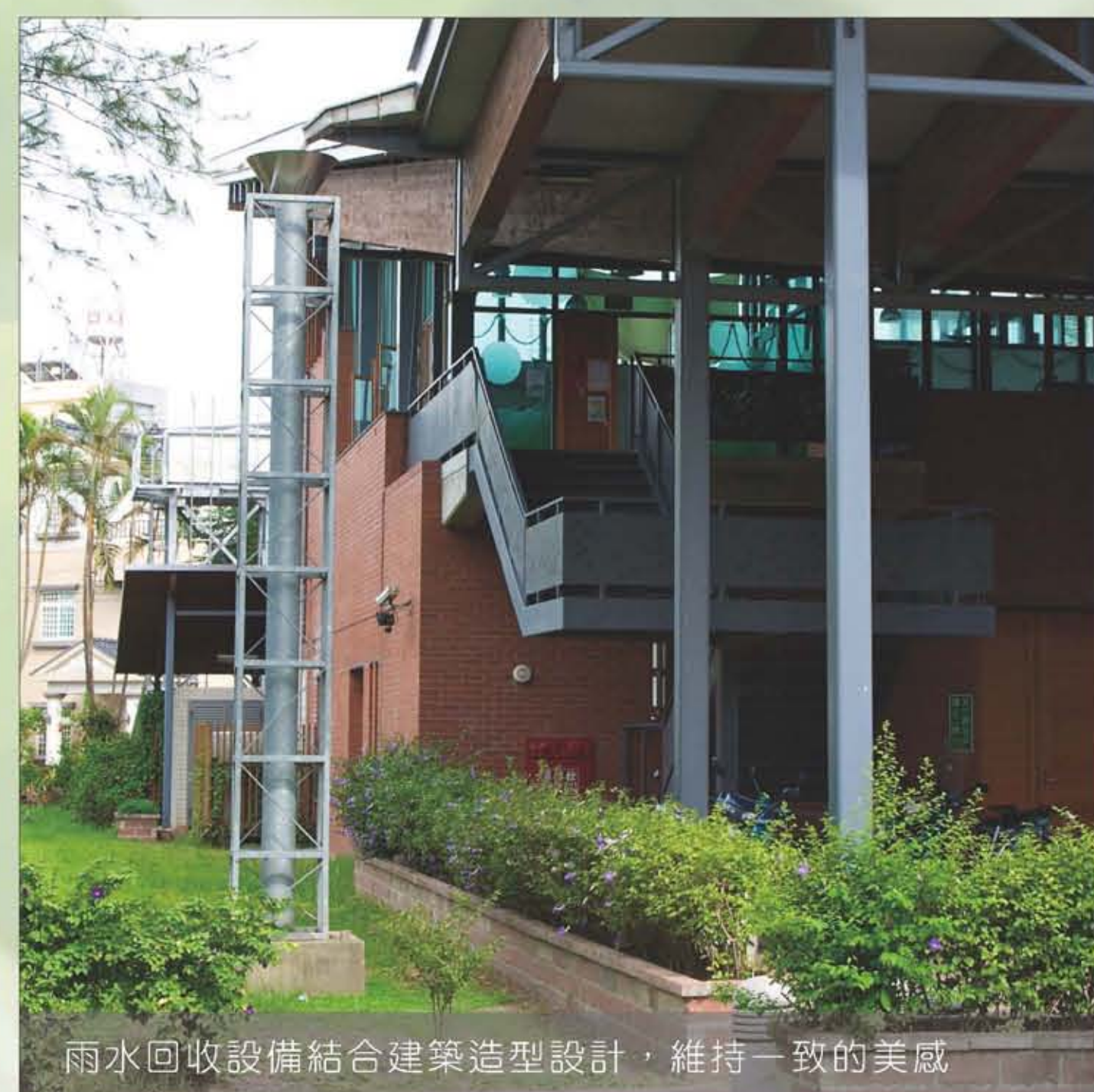
屋頂及建築物上半部採用集成材與鋼結構
