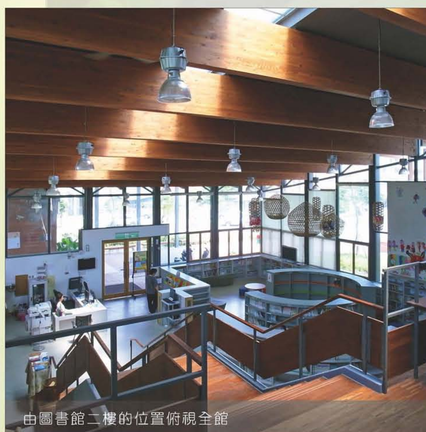
屋頂及建築物上半部採用集成材與鋼結構
