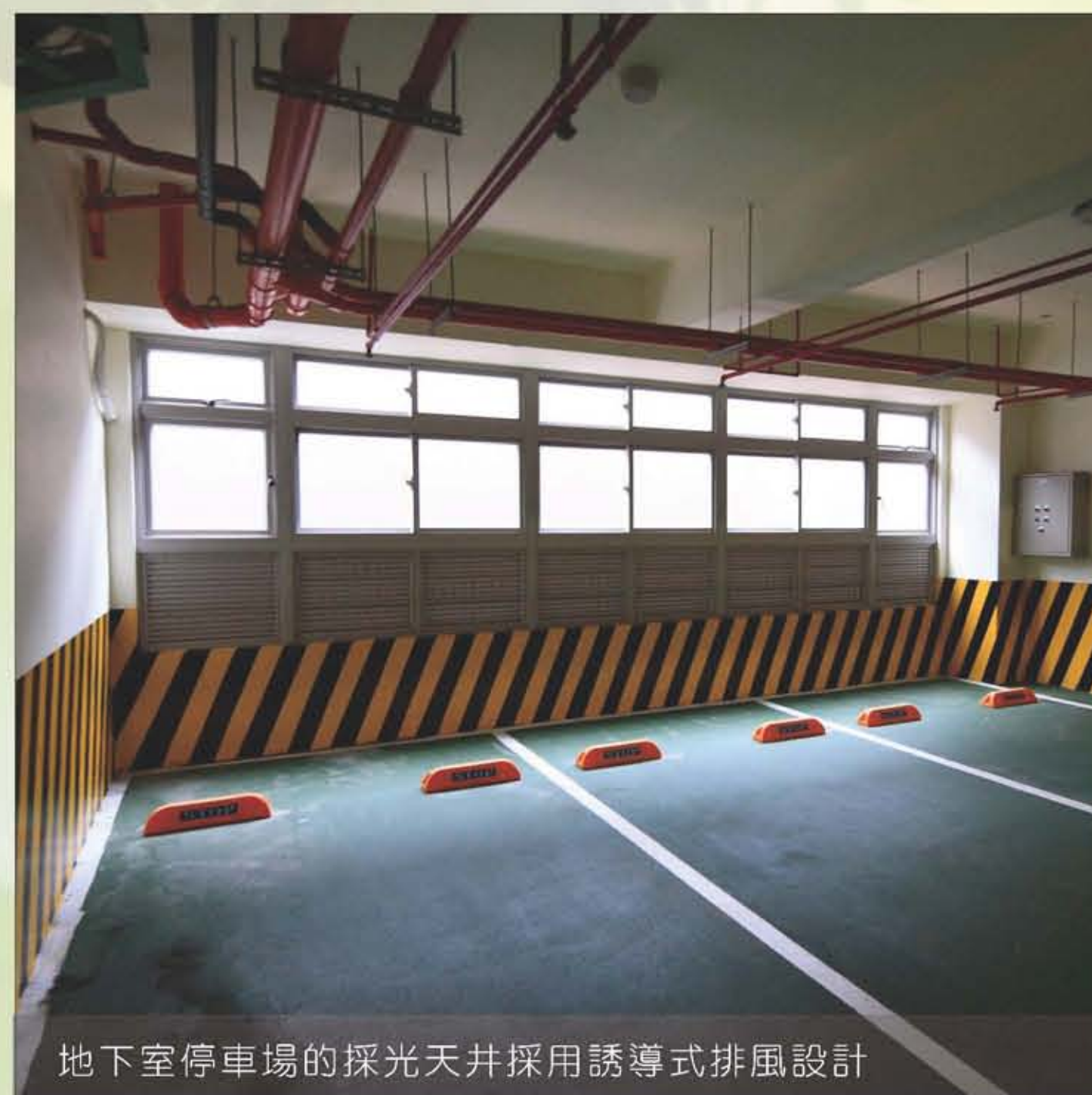
地下室停車場的採光天井採用誘導式排風設計
