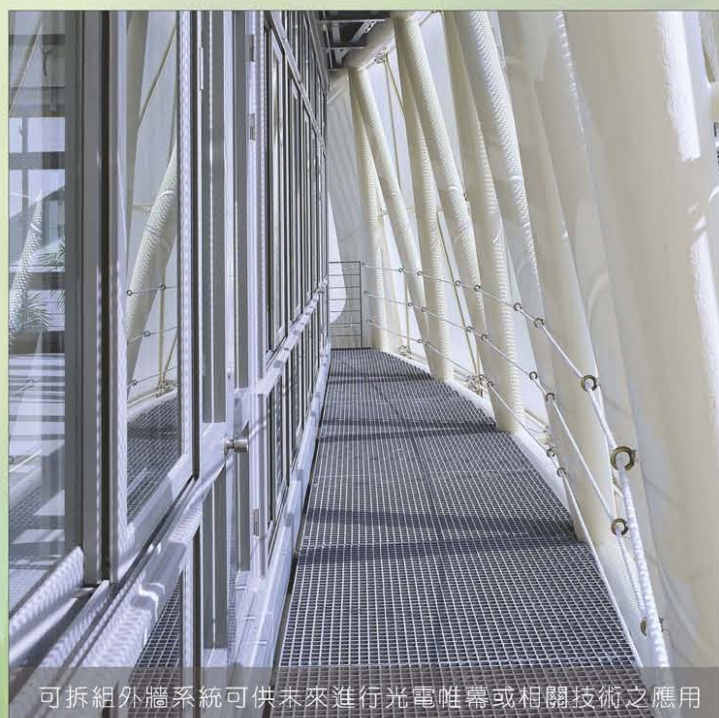
可拆卸外牆系統可供未來進行光電帷幕或相關技術之應用
