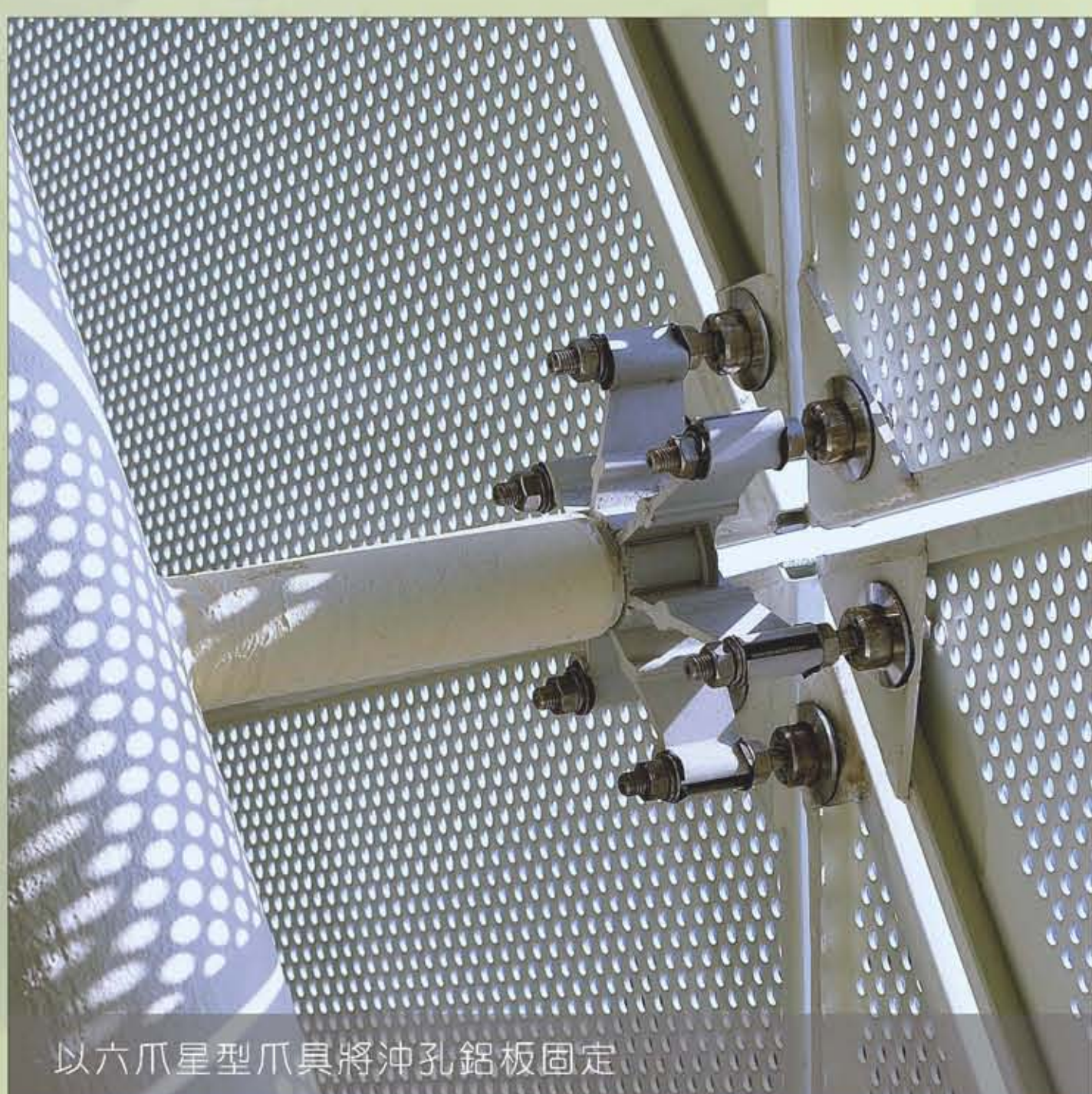
立面由許多四塊三角形鋁板組成的大三角形單元所構成
