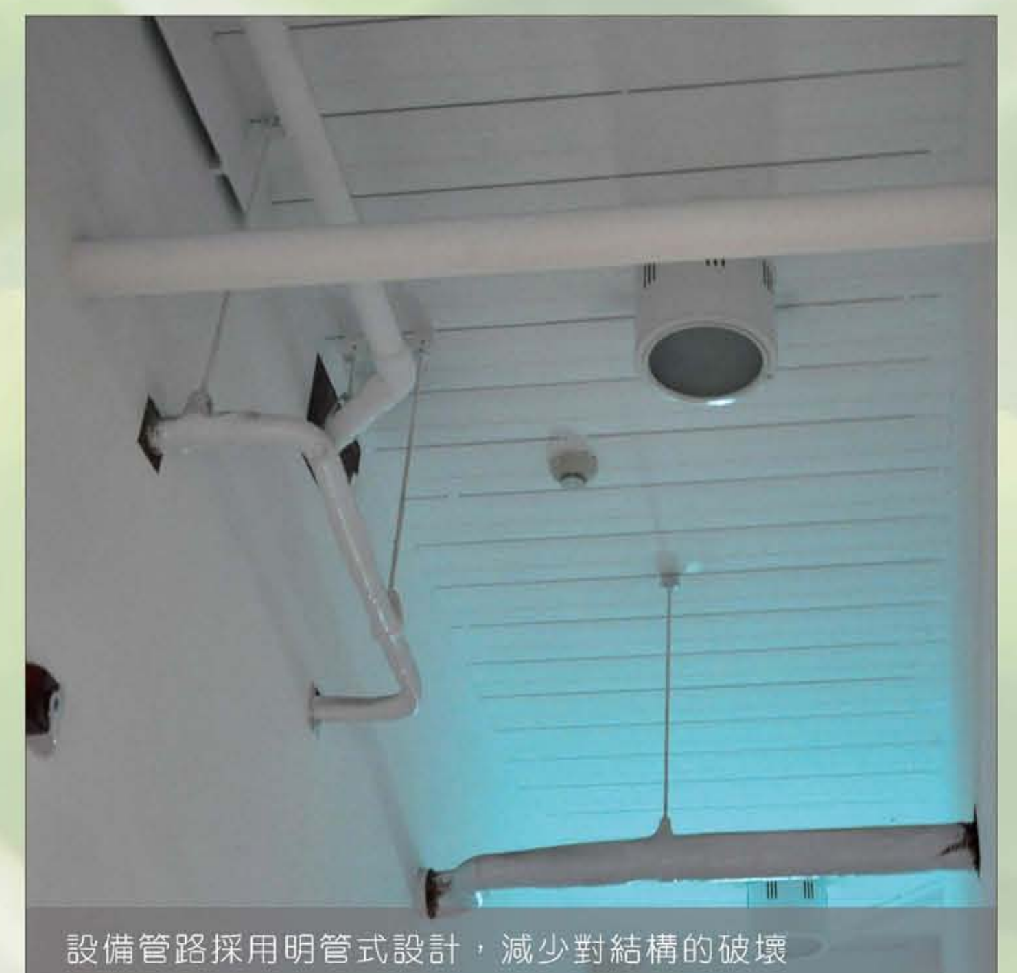
設備管路採用明管式設計，減少對結構的破壞
