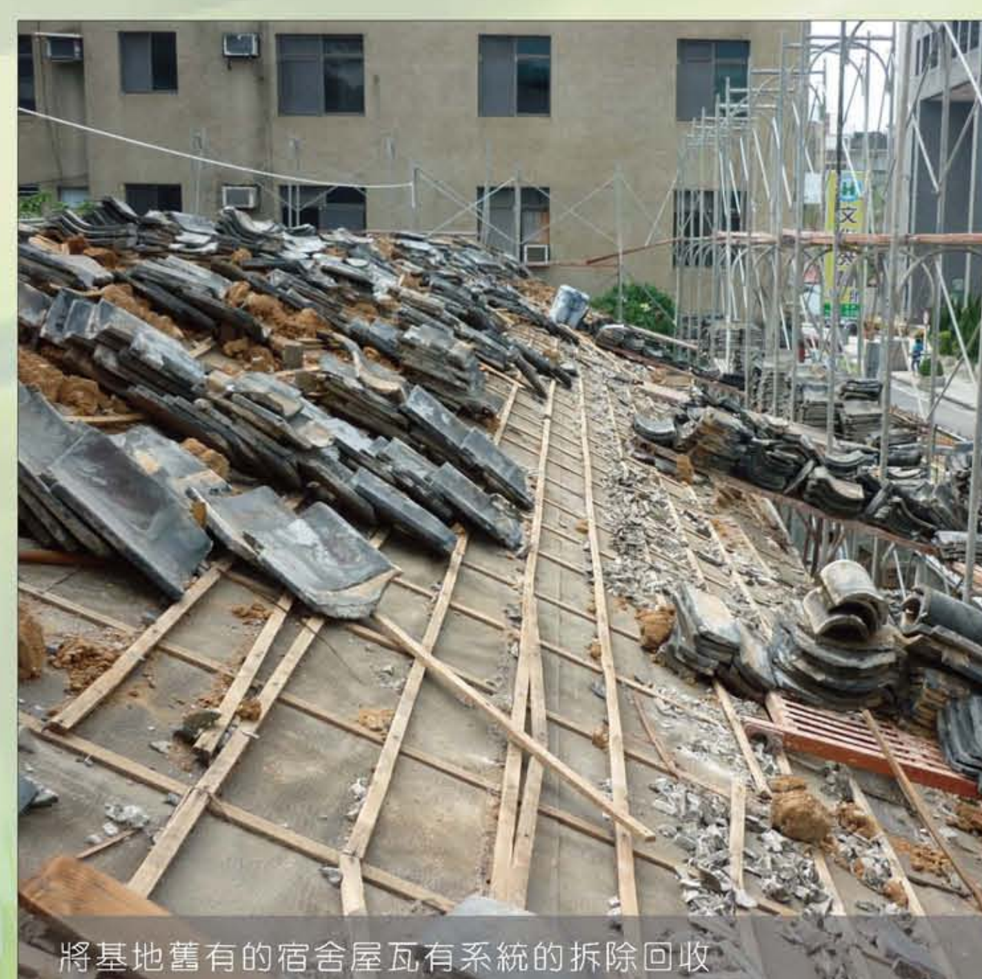
將基地舊有的宿舍屋瓦有系統的拆除回收
