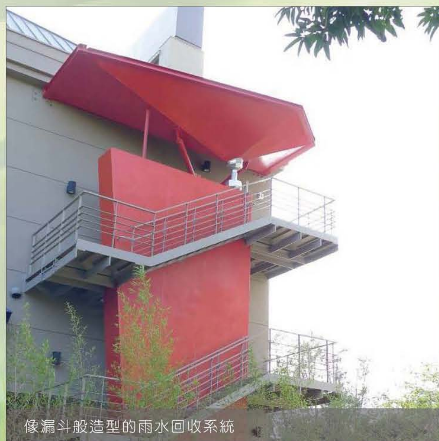
像漏斗般造型的雨水回收系統
