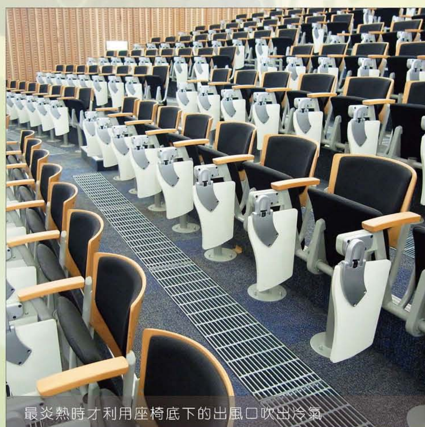
最炎熱時才利用座椅底下的出風口吹出冷氣
