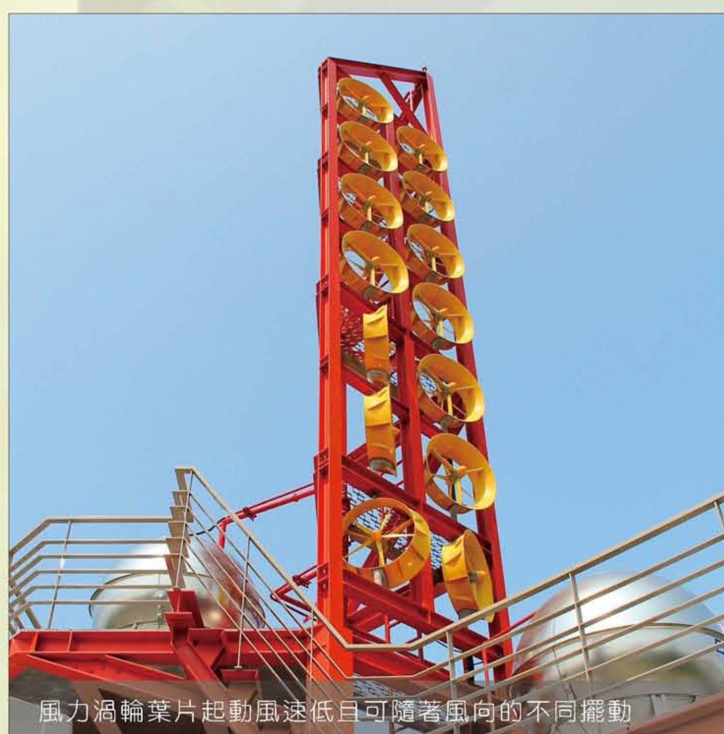
風力渦輪葉片起動風速低且可隨著風向的不同擺動
