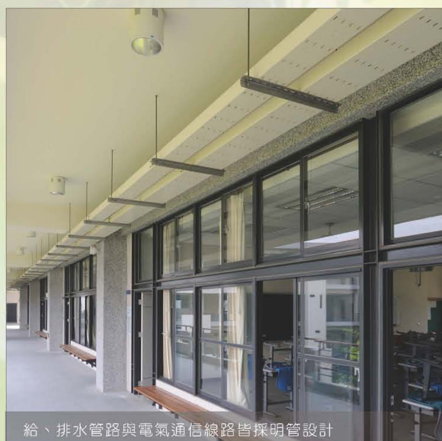
給、排水管路與電氣通信線路皆採用明管設計
