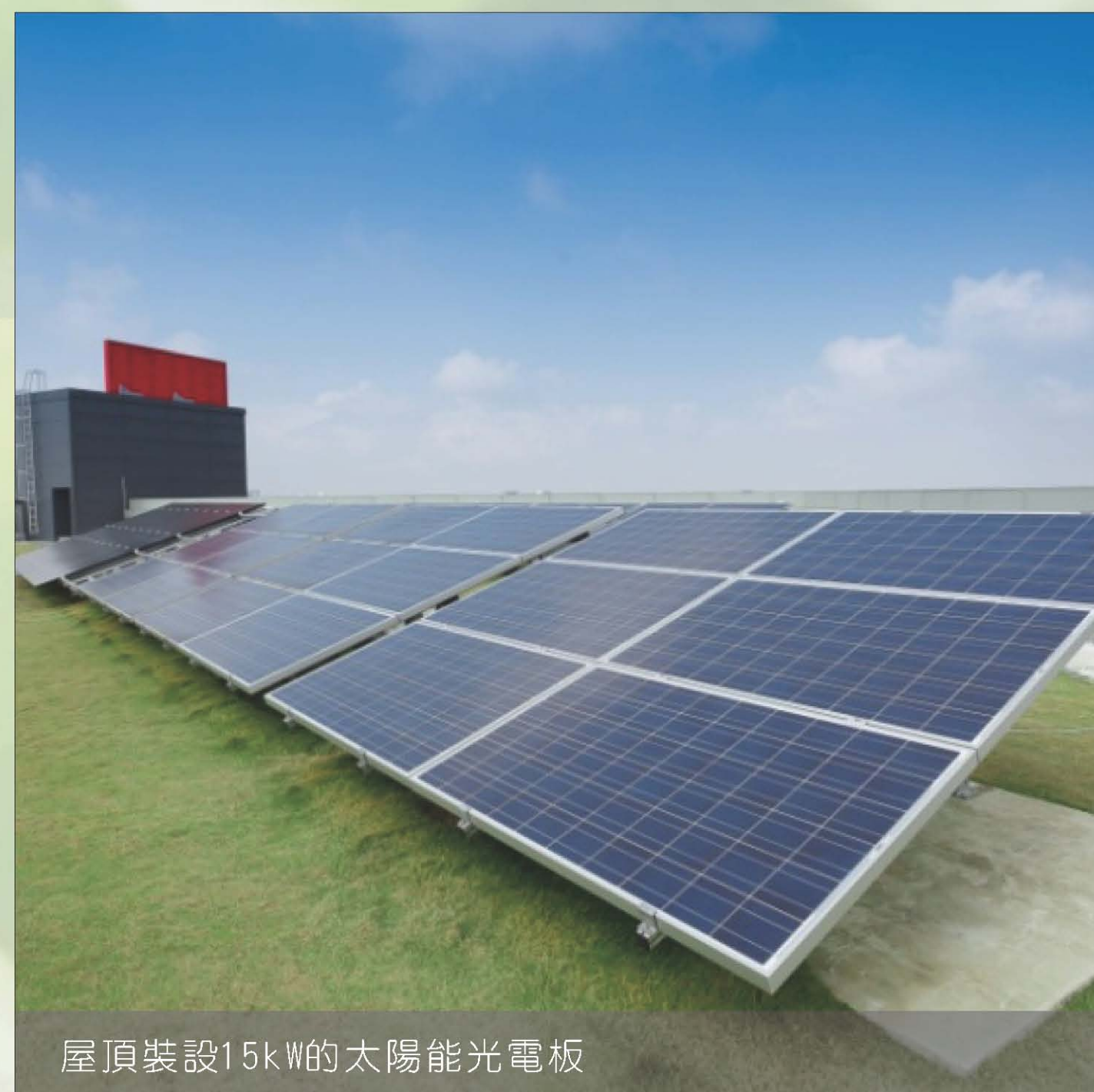
屋頂裝設15kW的太陽能光電板
