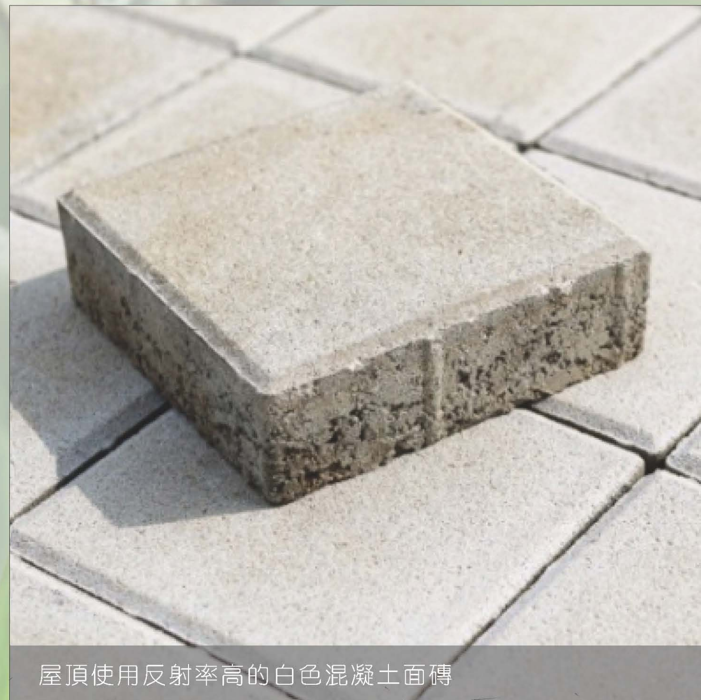
屋頂使用反射率高的白色混凝土面磚
