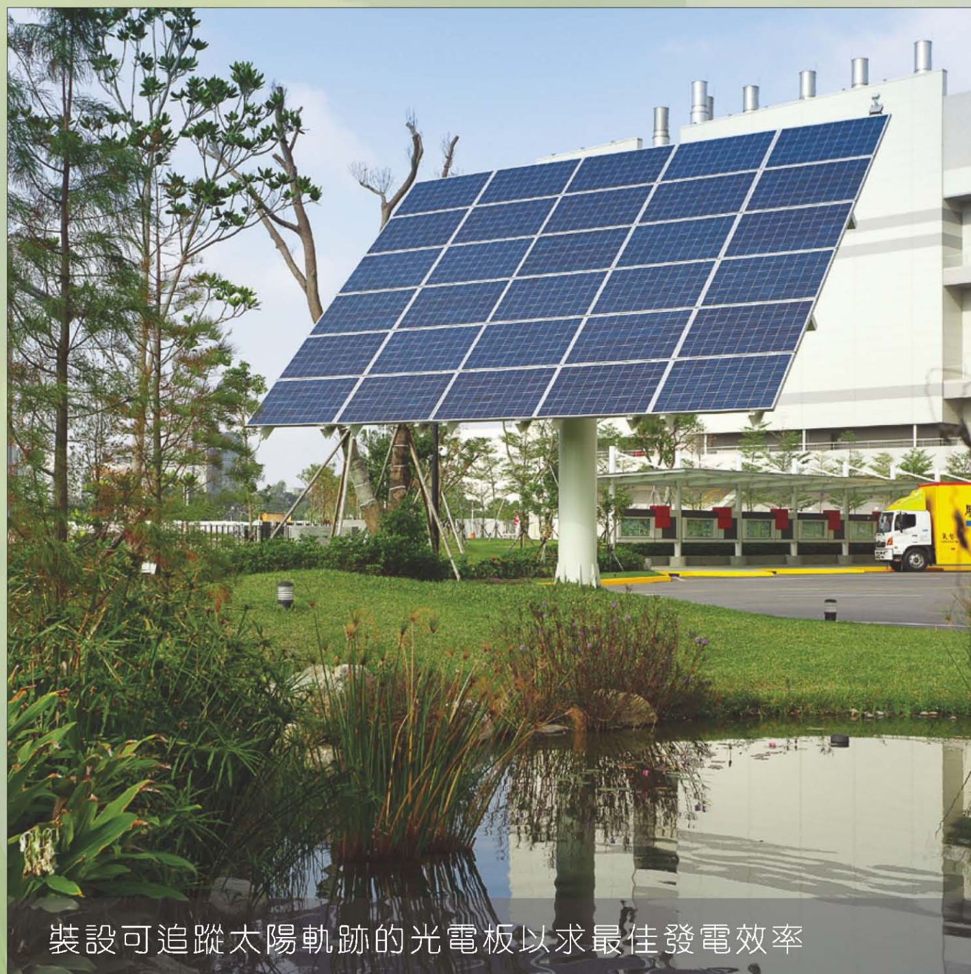
裝設可追蹤太陽軌跡的光電板以求最佳發電效率
