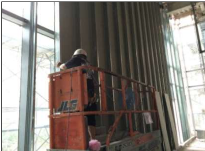
玻璃帷幕牆+水平橫擋(即空氣層)+石膏板輕隔間牆 玻璃帷幕牆+水平橫擋(即空氣層)+石膏板輕隔間牆
