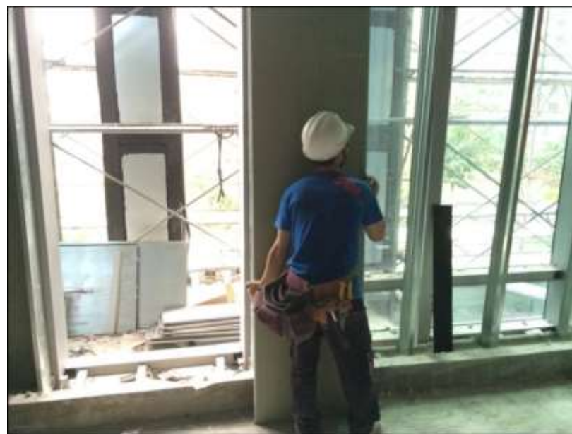
玻璃帷幕牆+水平橫擋(即空氣層)+石膏板輕隔間牆 玻璃帷幕牆+水平橫擋(即空氣層)+石膏板輕隔間牆
