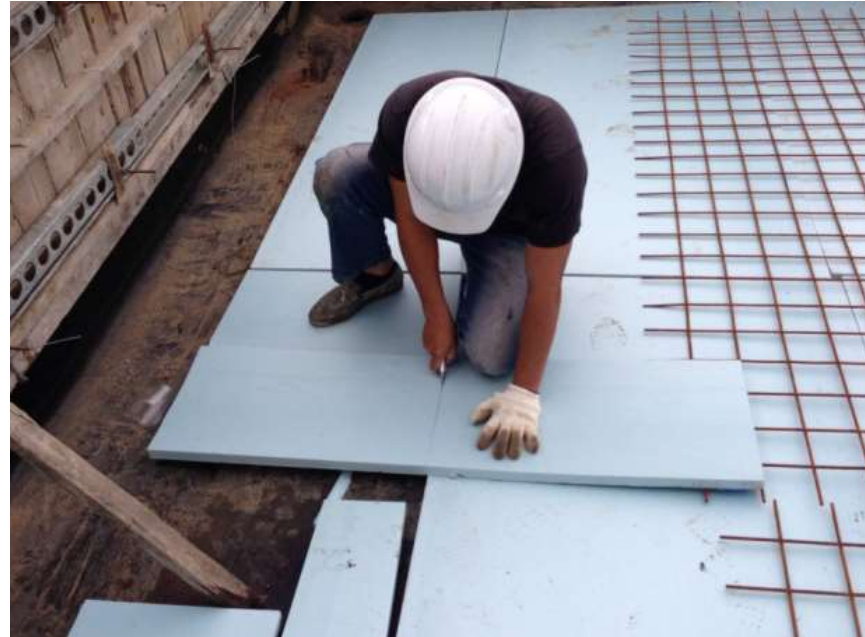
屋頂施作2.5公分PS隔熱板+點銲鋼線網
