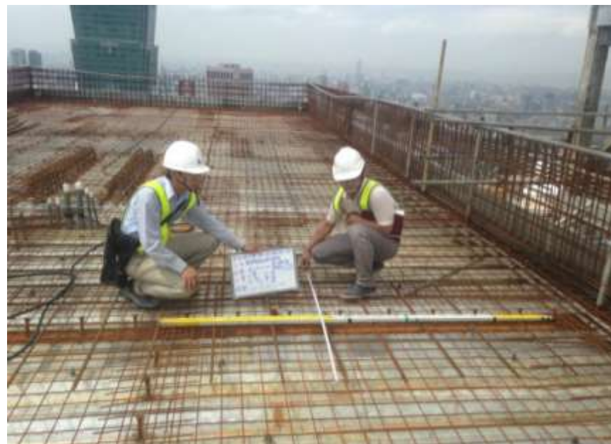
屋頂DECK板+點銲鋼線網
