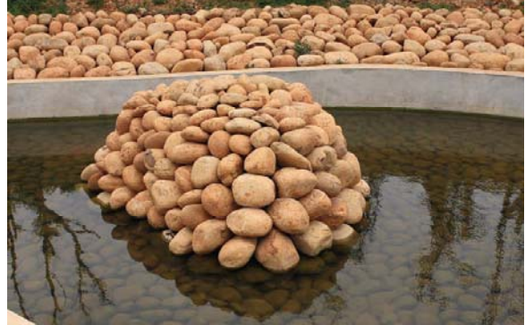
取材基地礫石層之卵礫石作為生態水池之乾排塊石邊坡
