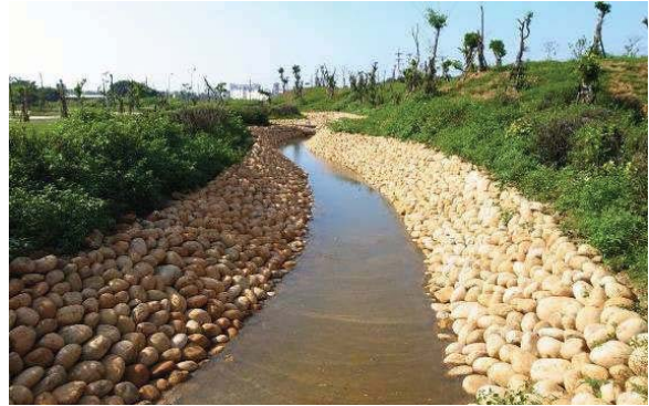
取材基地礫石層之卵礫石作為生態水池之乾排塊石邊坡
